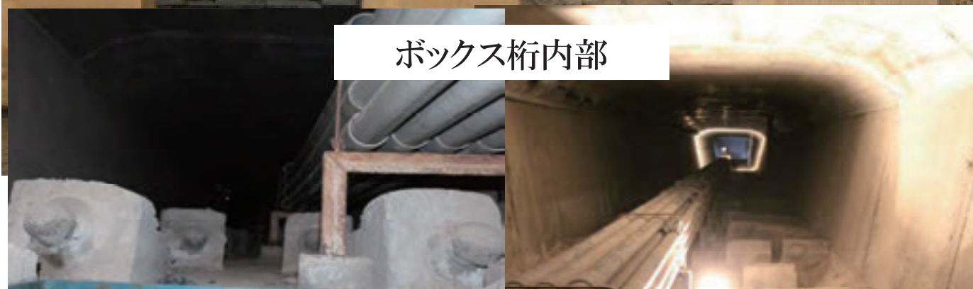
事例③ 大淀大橋 宮崎市 県道341号線
