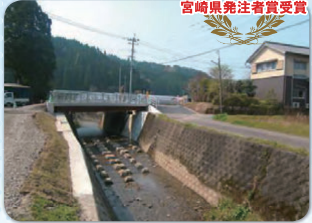
宮崎市（橋梁工事）
