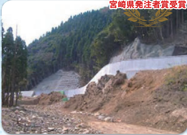
宮崎市（林道工事）
